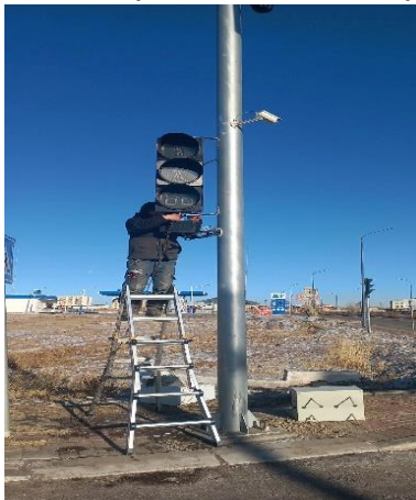
Автозамын баруун 4-н замын гэрлэн дохионы гэрлийг засварлаж гүйцэтгэлээ.
